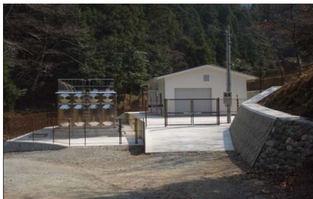
蔵川簡易水道浄水場及び配水池
