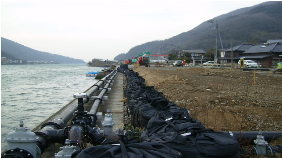
堤防整備のため仮設された配水管（上老松地区）
