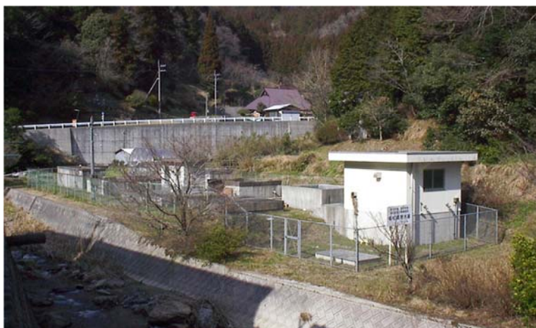
植松簡易水道浄水場
