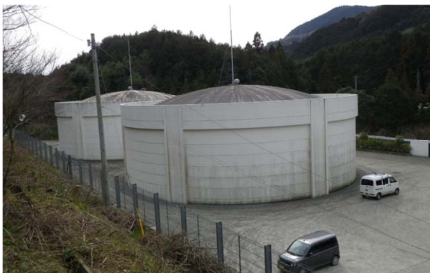
大洲市上水道五郎配水池
