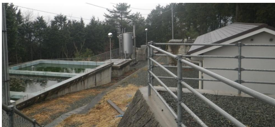
中央簡易水道(肱川)予子林浄水場
