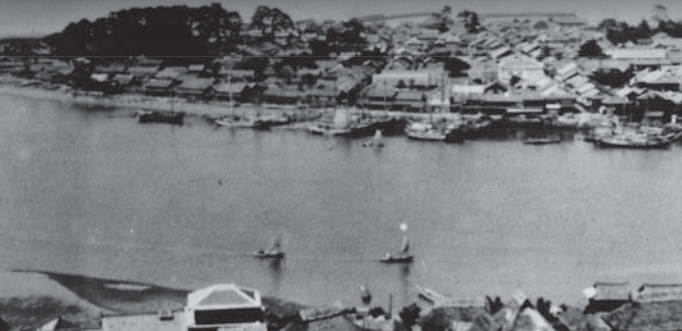
나가하마 대교 건설 전
