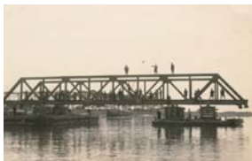
用台船移送桥桁 照片提供者：细野房雄氏
