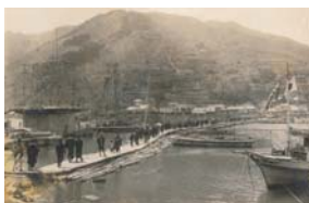
施工中架起的浮桥 照片提供者：细野房雄氏
