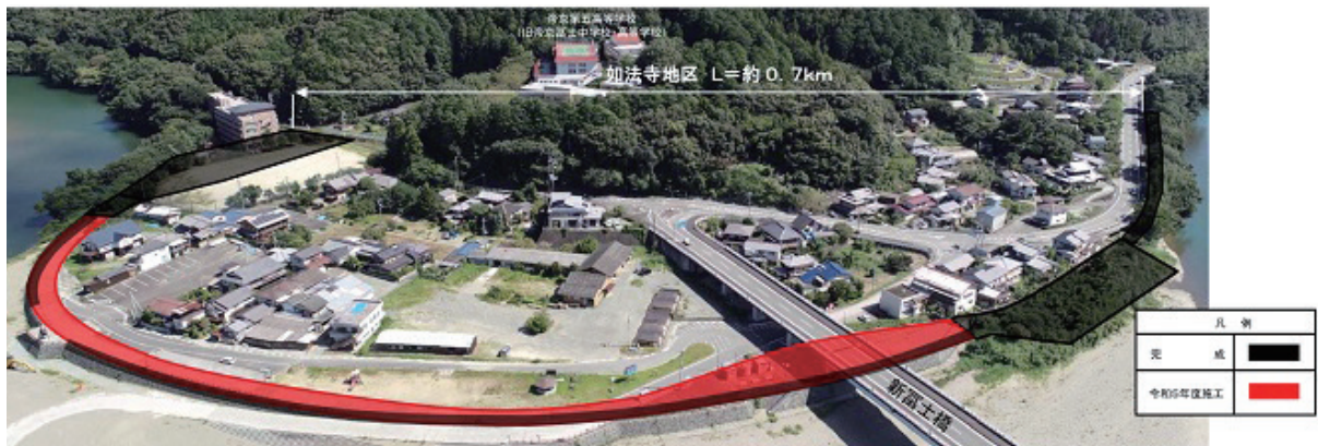
〔図 2-12〕 緊急治水対策工事の進捗状況 如法寺地区（2024年1月現在）
