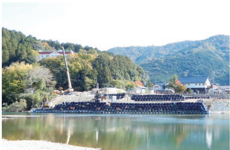
[写真 2-6] 如法寺地区の築堤工事の状況
