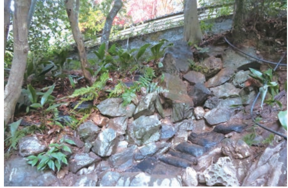
[写真 2-13] 確認された石積
