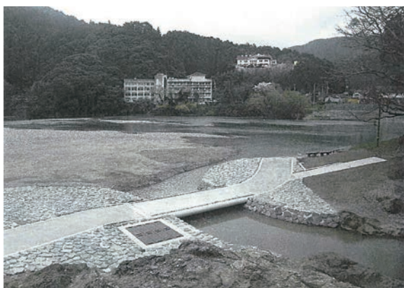
[写真 2-4] 渡河橋 (平成26年度整備時) (平成26年 完了申請より)
