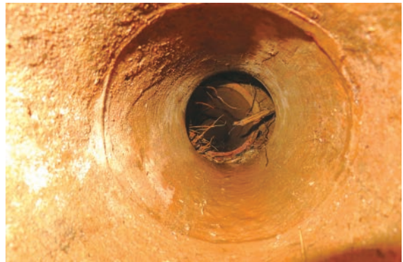
[写真 2-19] 土管 内部
