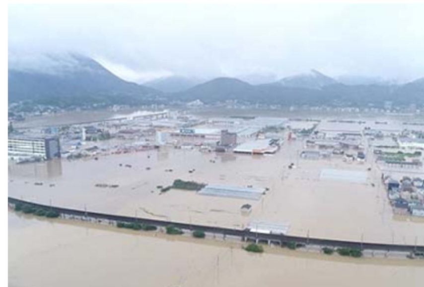
図4-5 平成30年7月東大洲地区浸水状況
