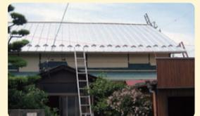
重い屋根は、地震の揺れを受けると振り子のように大きく揺れ、建物を倒壊させる恐れがあります。軽い屋根に変えることにより、耐震性を高める事が可能です。
