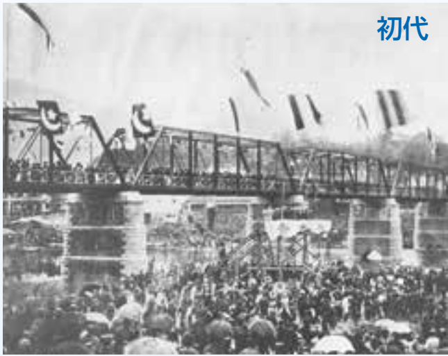
大正2年9月 肱川橋開通式 出典：大洲市誌写真版
