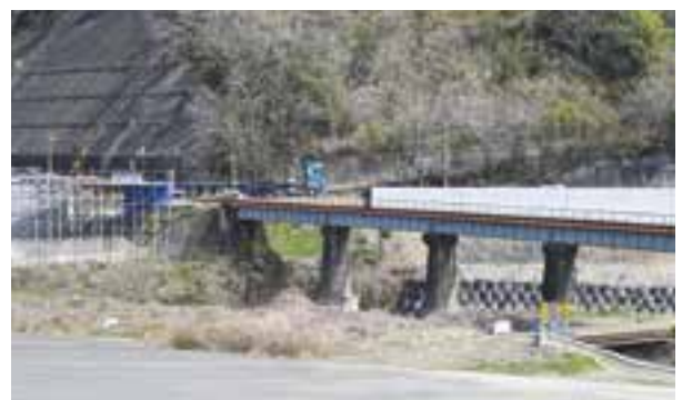
JR橋梁区間 現地状況 3月時点
