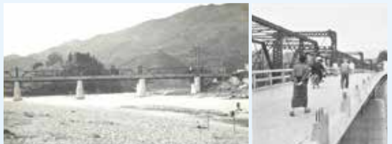
3代目工事中の写真（2代目と3代目が並んでいる）
