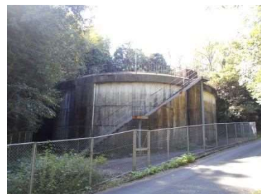
正山配水池（S47）
