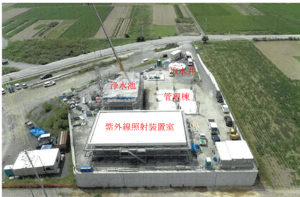
菅田浄水場 上空より
