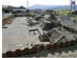
建設中の災害公営住宅（森団地）
