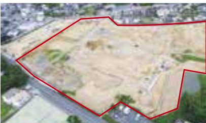
【造成中の工業用地】
