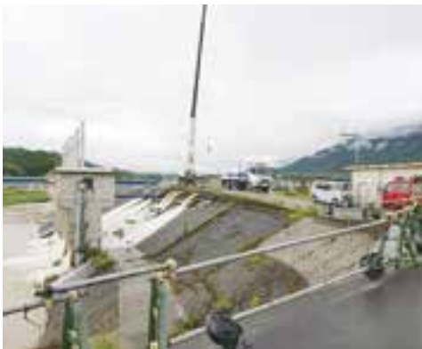
【稼働中の排水ポンプ車（都谷川排水樋門）】
