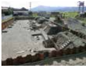
建設中の災害公営住宅（森団地）
