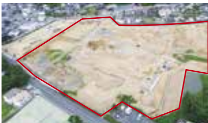
【造成中の工業用地】
