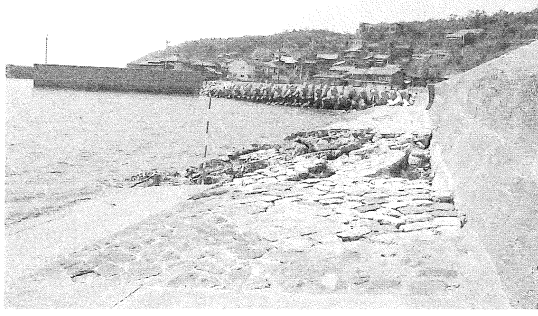
台風18号の影響により被災した青島漁港物揚場
