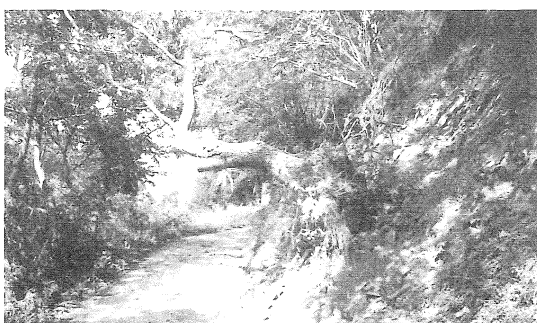
台風18号の影響で被災した町道日ノ浦松ノ久保線
