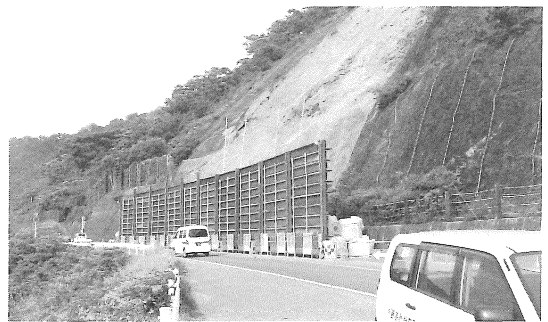
片側交互通行が続く崩落現場
