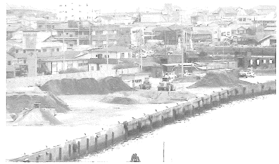
本年度から改修工事がスタートする長浜港東岸壁
