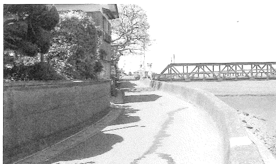
河川整備と連携して改良される県道長浜中村線
