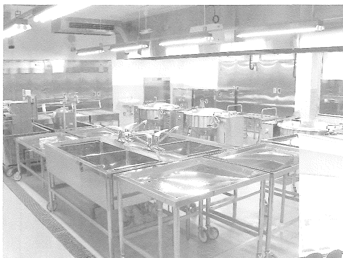
真新しい機器が並ぶ厨房（1階） 〈調理能力 400食〉
