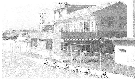
完成した給食施設（長浜中学校）
