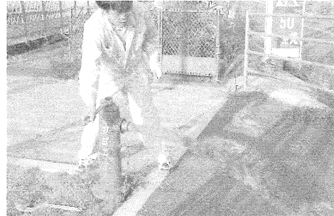
工事後の赤水排出作業
