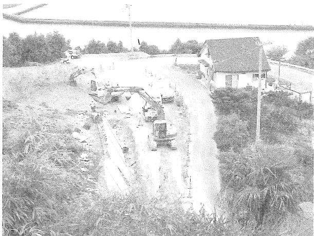
改良工事が進む町道長浜戒川線
