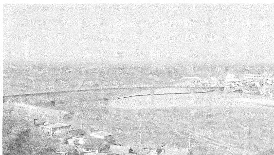
先般国によって砂が除去された脘川河口
