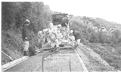
順次行われている農道舗装工事
