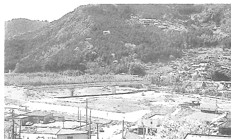
改築工事が進む白滝大橋
