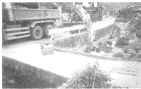
土砂の取り除きが行われる土居川(昨年11月)
