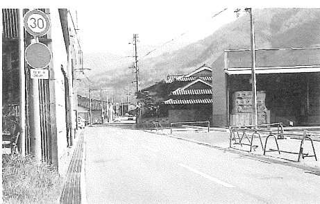
県道の早期整備が望まれる仁久地区
