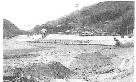
築堤工事が進む田淵地区
