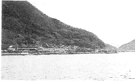
早期の河川改修が望まれる仁久地区
