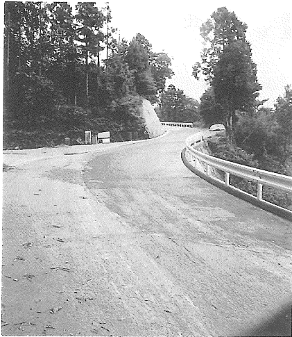
改良工事が継続される町道上老松一ノ瀬線
