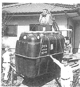
合併処理浄化槽設置工事(9年度)
