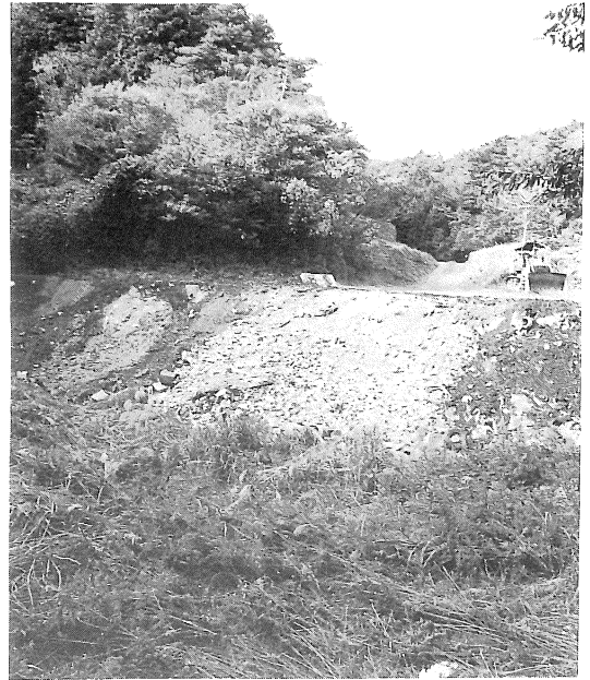
昨年度閉鎖された長浜町最終処分場
