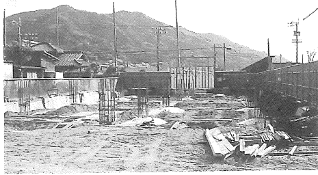
工事が進む保健センター建設現場
