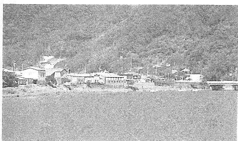
築堤が予定される大和地区
