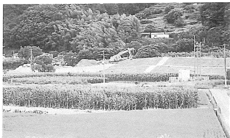
整備が進む豊中堤防
