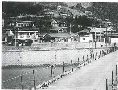
築堤が予定される加屋地区
