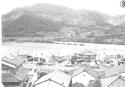
⑧ 肱川の増水により浸水した白滝地区
