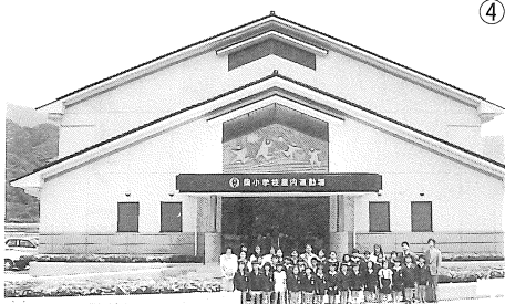
④ 完成した柴小学校の室内運動場
