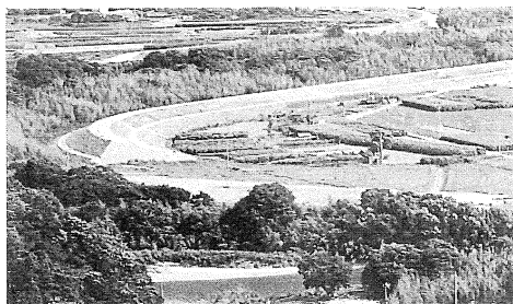
急ピッチに整備が行われる河川堤防
