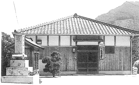
平成5年に完成した下成集会所
