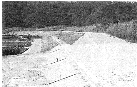
堤防整備が進められる柴地区
