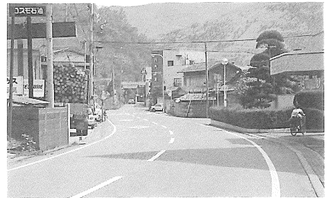
法線決定等に困難を強いられている県道
