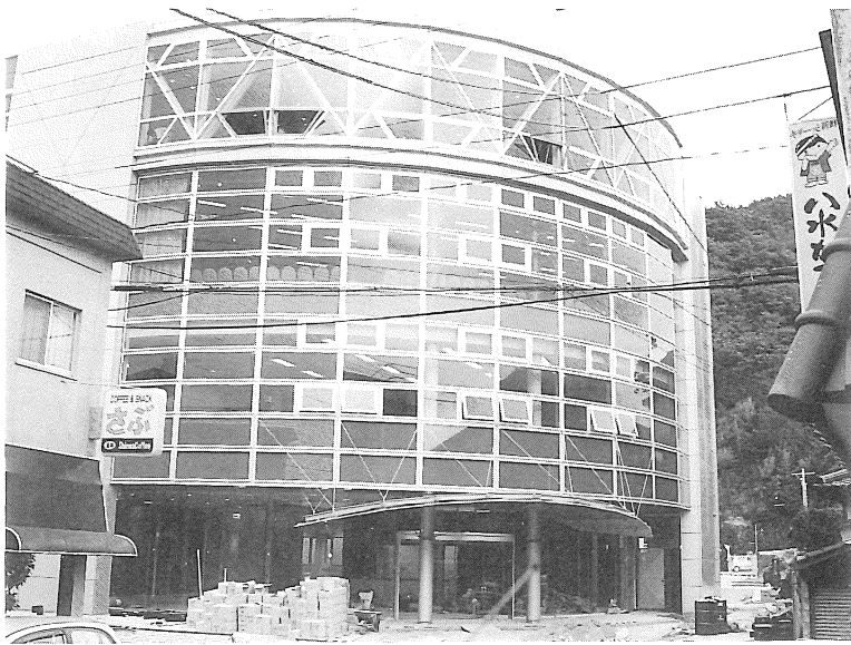
完成間近の長浜町ふれあい会館
