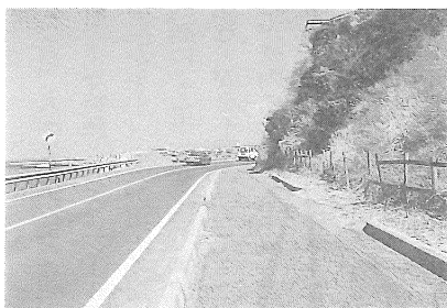
沖浦の鵜の口付近の国道 道路の幅員が広いので、スピードの出し過ぎによる大事故が発生している。スピードの出し過ぎとハンドル操作に注意。
