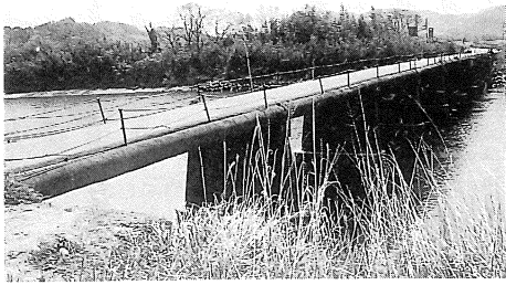
建設省と協議が進められている白滝橋
