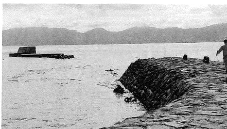
波浪のため崩壊した青島の防波堤
