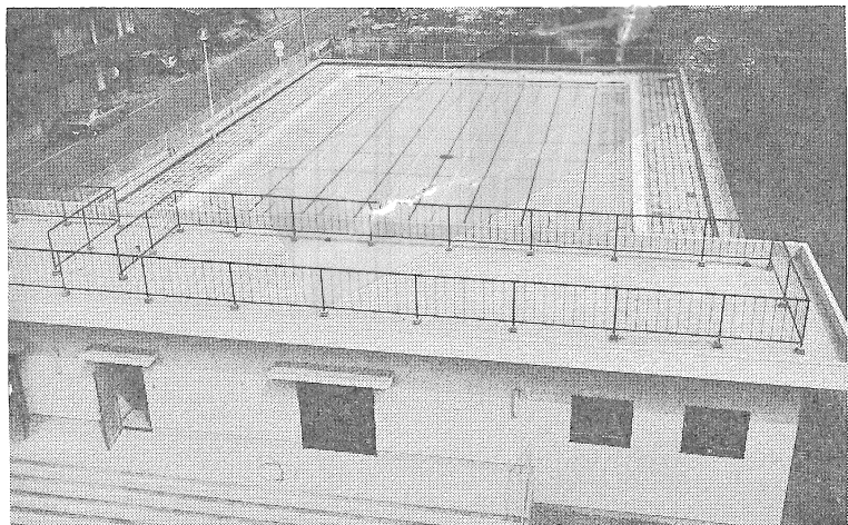
完成した喜多小学校プール
