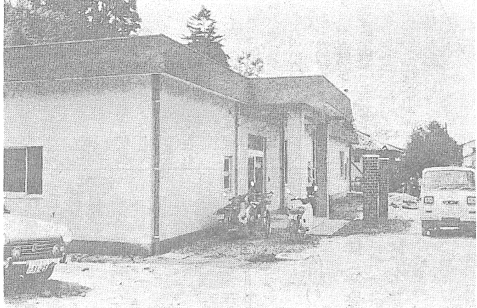
完成した老人ホーム
