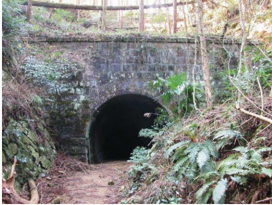
切石と煉瓦造りの河内トンネル
