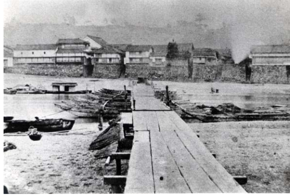
肱川に初めて架けられた橋 浮亀橋
