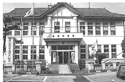
老朽化の進む役場本庁舎
