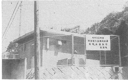
須沢に完成した簡易水道施設
