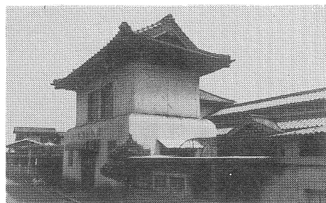
施設の老朽化で取り壊される長浜水族館
