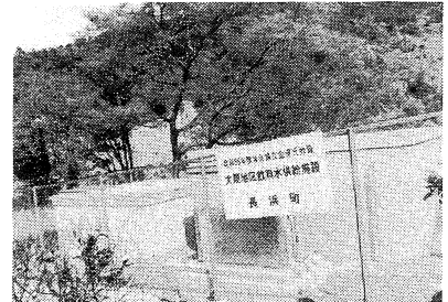
大屋地区飲料水供給施設
