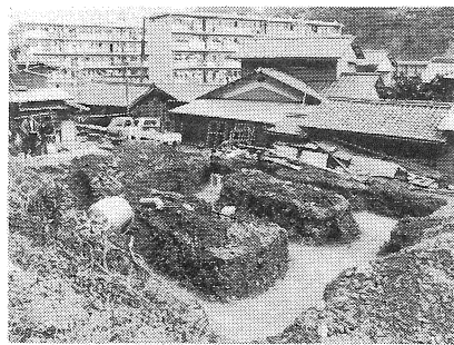
始まった小浦集会所建設工事 (1月12日現在)
