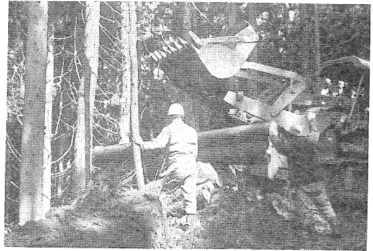
自然環境をこわさないことにも注意が払われ、道路開設のため切り開いた地ハダは外部から見えないよう配慮されている
