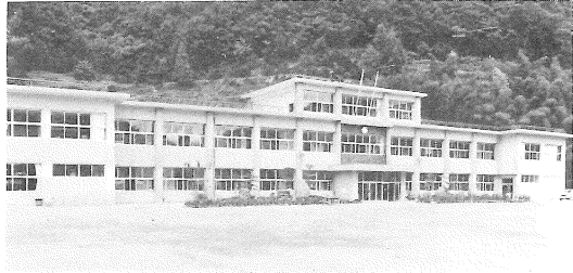
大和小学校改築 (47・3・20)
