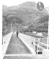
大和橋歩道橋完成(48・3・28)
