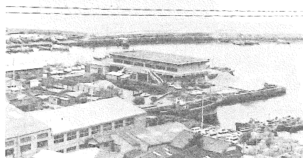
長浜港ふ頭(9,900平方メートル)完成 (36・3・31)
