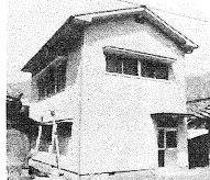
新造替地集会所 完成 (49・2・28)
