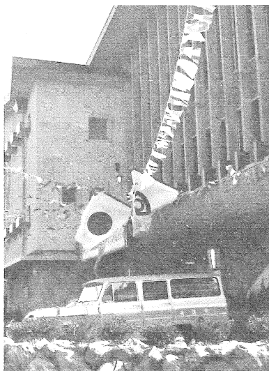
文化のバレス「長浜町体育館」完成(39・11・30)当時は関西随一の施設といわれた
