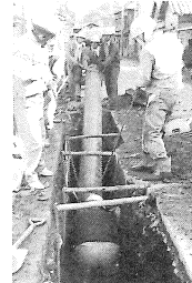
工業用水道完成 (47・3・31)
