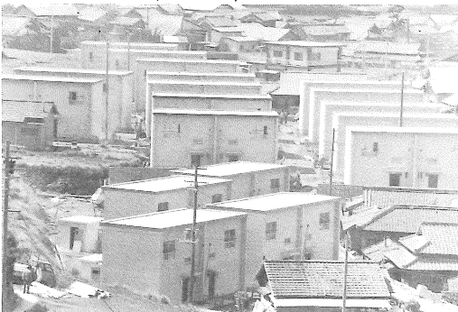
出海に町営住宅18むね36戸完成(47・3・31)
