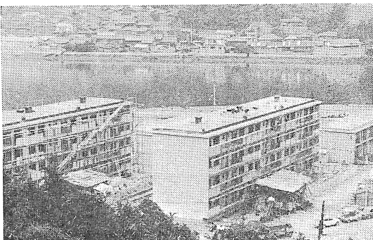
小浦住宅2むね48戸が完成することによって、より一層団地らしくなってゆく。写真右端の第1期工事で完成した分を合わせると全部で78戸の完成となる
