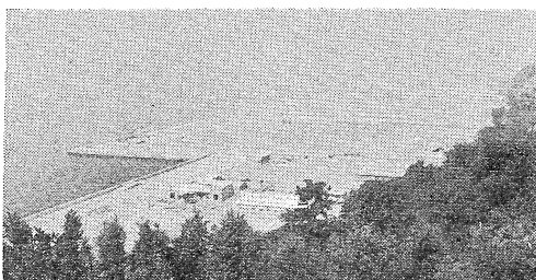
昭和サボア炭素電極工場の建設着工間近い晴海団地。第一次分譲地にはすでに地場産業の工場が立ちはじめ一部では操業も始まっています。
