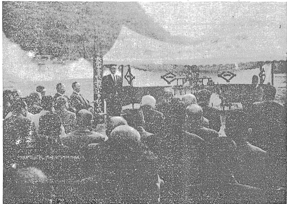
江湖の中学校敷地でなされた起工式
