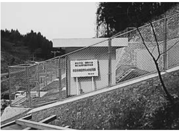
(百合谷地区飲料水供給施設)
