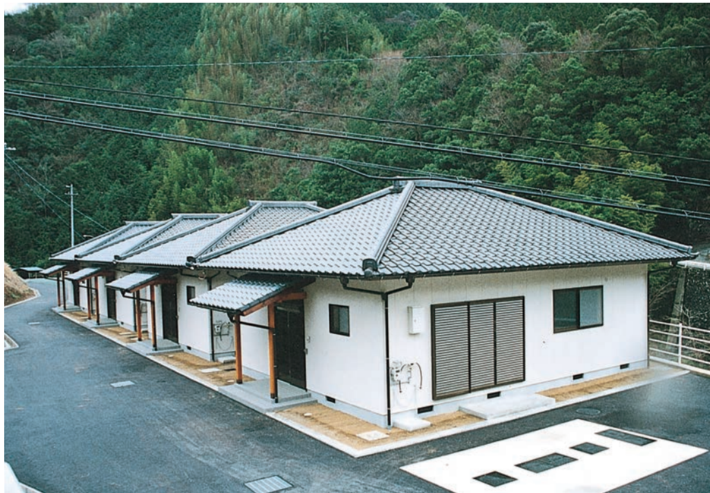
河辺村大字河都 木造平屋建 1 戸 56.8㎡
